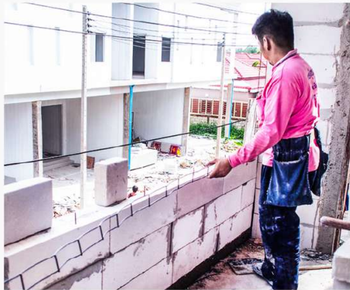
2 วางบนส่วนที่จะเทคานกับหลัง
