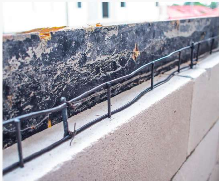
4 ตีแบบเพื่อเทคอนกรีต
