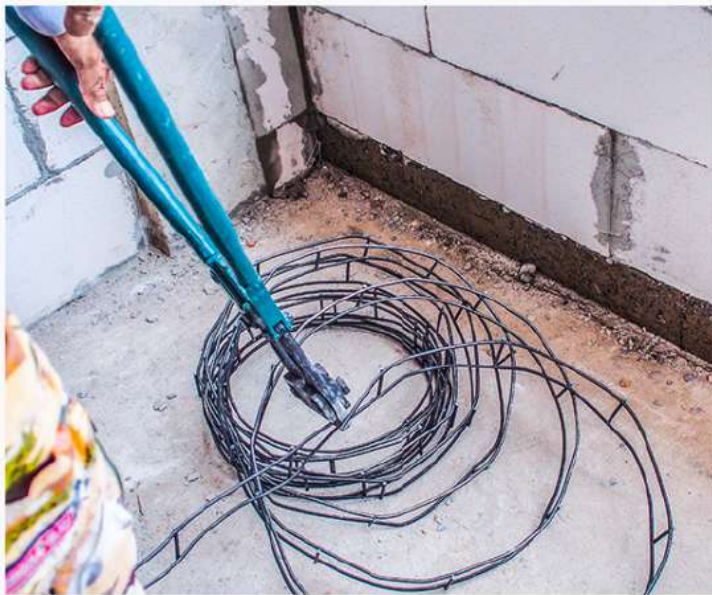
1 ตัดเหล็กจากม้วนสำเร็จ
